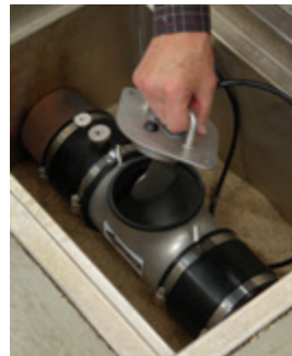
JAFO RAT - EXX skal være lett tilgjengelig under f.eks en gulvplate.
