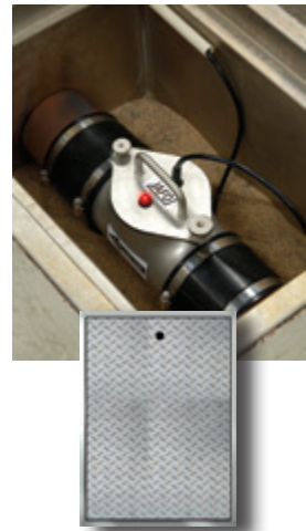
JAFO RAT - EXX skal være lett tilgjengelig under f.eks en gulvplate.
