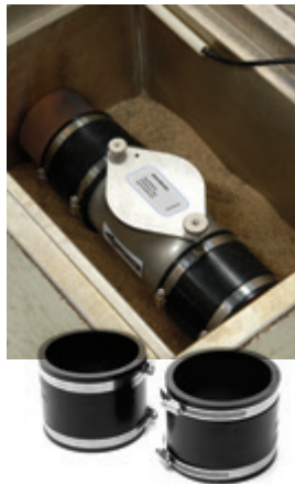
JAFO RAT - EXX skal være lett tilgjengelig under f.eks en gulvplate.
